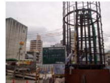
鉄骨コンクリート杭
