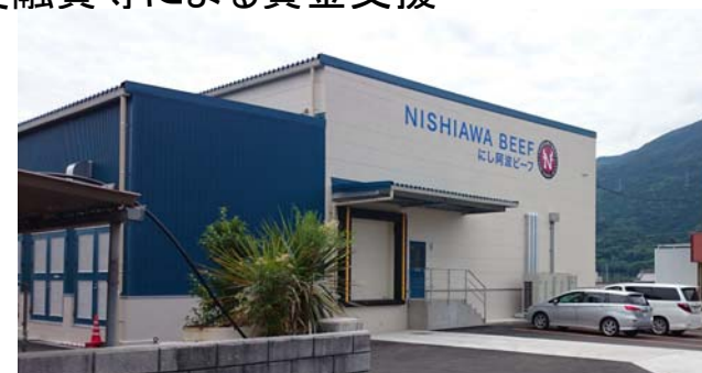
完成した食肉処理施設
