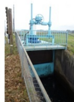
簡易設置事例 (那須野ヶ原)
