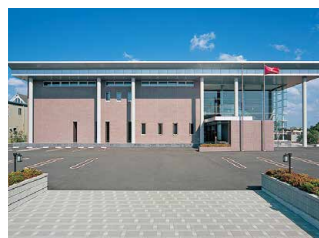
■研修棟と宿泊棟から成る研修会館。食堂やロビーラウンジも完備。
